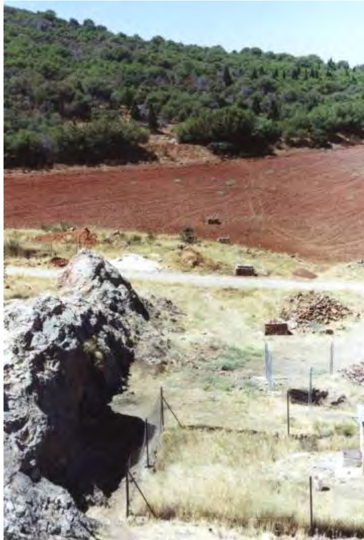
Fig. 12. Vista general en superficie de los pozos de registro o chimeneas, que reflejan bien la disposición del brazo captante dispuesto en perpendicular a la pendiente
