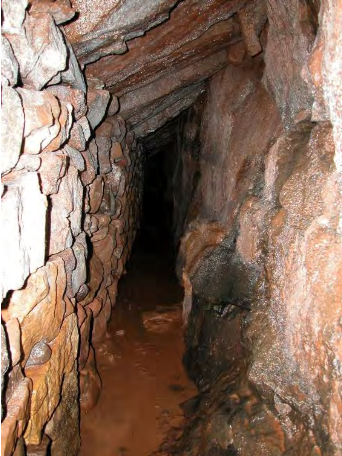
Fig. 10. Interior de uno de los brazos captantes del qanat . El agua rezuma por la pared de roca madre (a la derecha de la imagen) y cae al suelo arcilloso, que es impermeable y permite que el agua discurra hasta la alcubilla. Obsérvese que no resulta factible recoger agua de los brazos captantes a través de los pozos de registro; se trata de galerías que capturan el agua y la conducen, pero no la almacenan.
