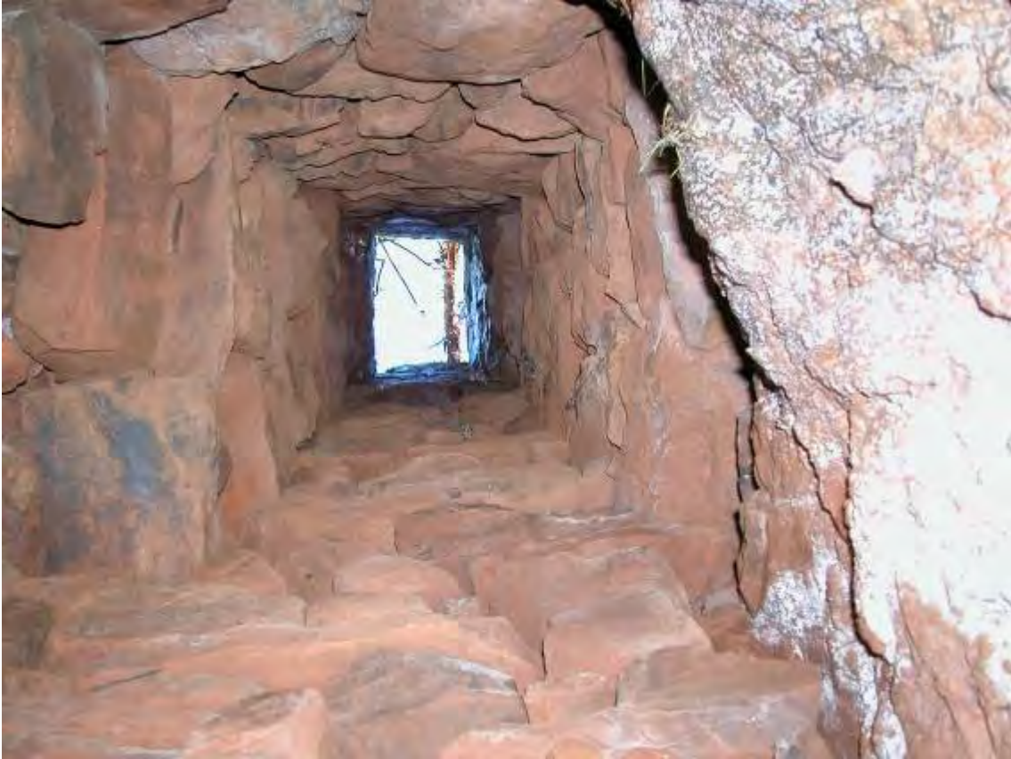
Fig. 11. Vista desde el interior de una de las chimeneas o pozos de registro, Obsérvese la roca madre en primer término y la construcción de mampostería en seco que se levanta hasta llegar a la superficie
